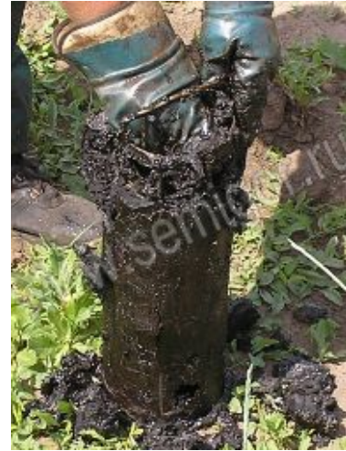
Извлечение поршня из ловушки
