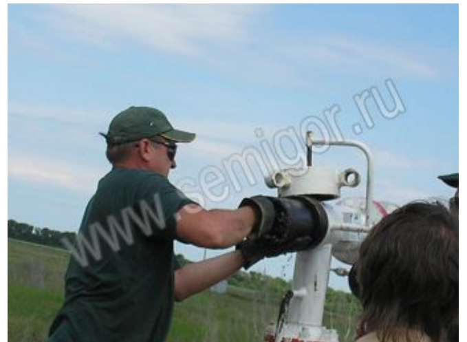
Извлечение корзины (ловушки) с отложениями АСПО и поршнем из камеры приема
