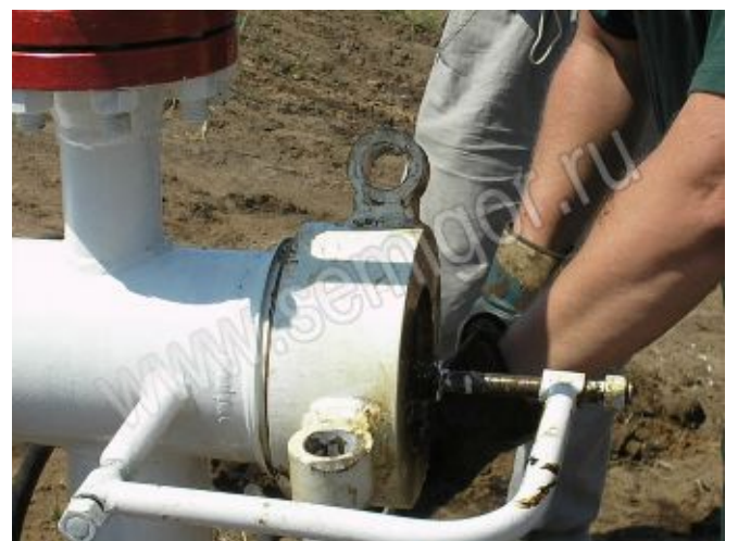
Закрытие крышки камеры запуска
