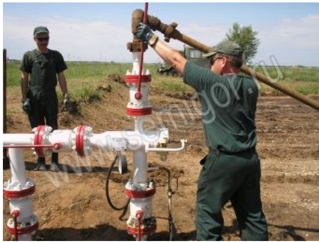
Подсоединение резервного насоса ЦА-320 для поддавливания поршня
