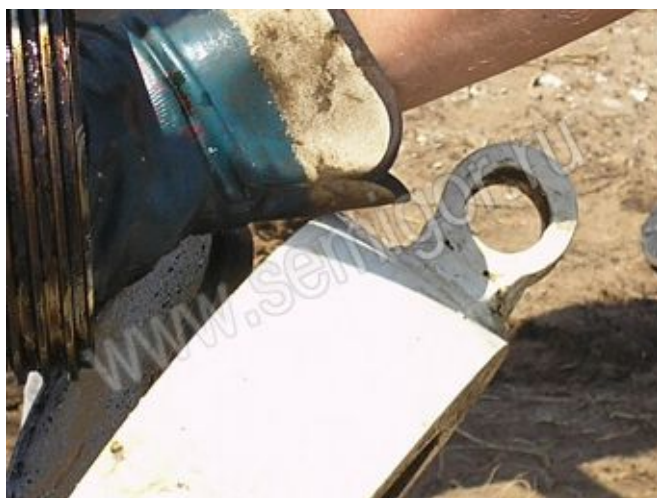
Запасовка поршня в камеру запуска.
