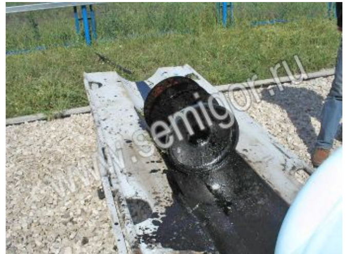
Очистной поршень Семигор-3Д1М-273 по- сле очистки полости нефтепровода (вид сза- ди).
