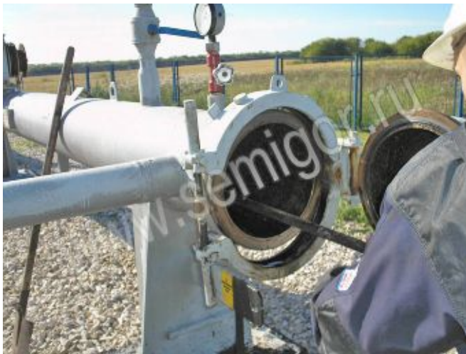
Подготовка камеры запуска, с очистным поршнем внутри, к опрессовке нефтью.
