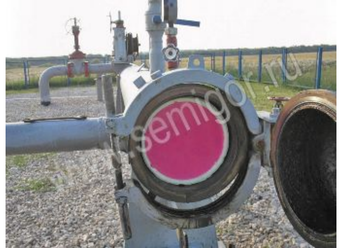
Очистной поршень Семигор-ЛП-273 в камере запуска.
