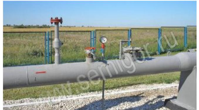
Положение сигнализатора прохождения поршня, перед пропуском очистного поршня. Положение флажка - горизонтально.
