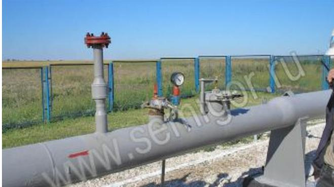
Положение сигнализатора прохождения поршня, после прохождения очистного поршня. Положение флажка - вертикально
