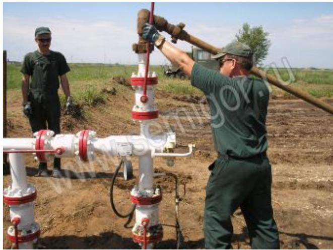
Подсоединение резервного насоса ЦА-320 для поддавливания поршня
