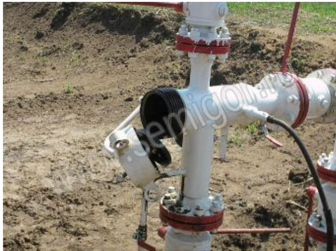
Стационарная камера запуска очистного поршня
