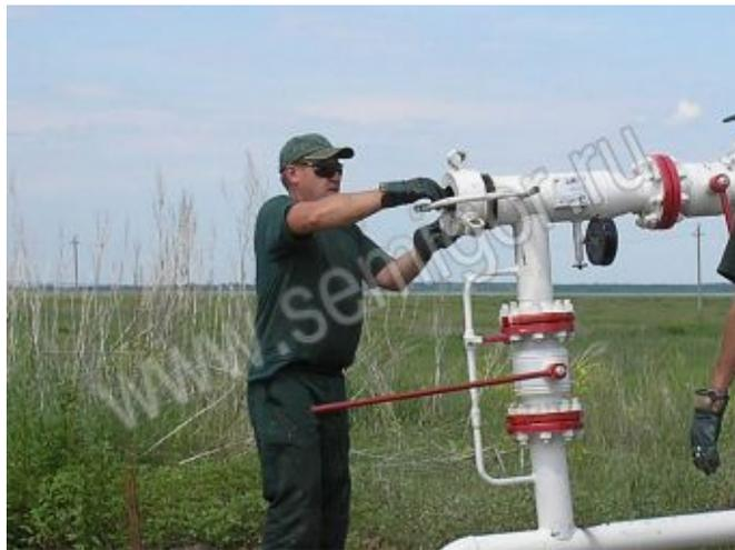
Стационарная камера приема очистного поршня
